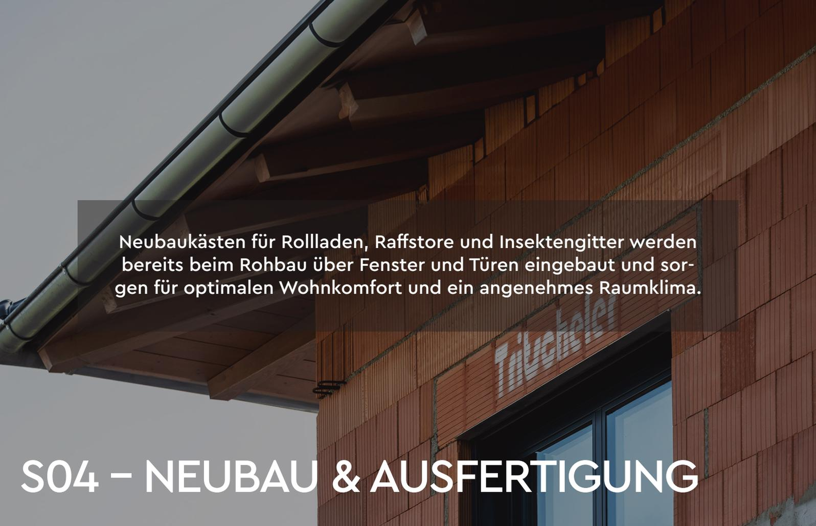
Neubaukästen für Rollläden, Raffstore und Insektengitter werden bereits beim Rohbau über Fenster und Türen eingebaut und sorgen für optimalen Wohnkomfort und ein angenehmes Raumklima.
